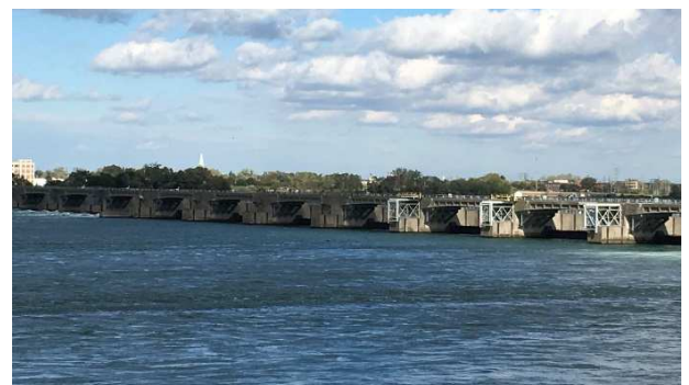
カナダ滝の上流に設置された可動堰
