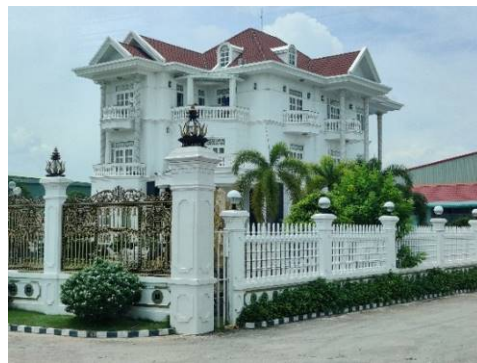
写真1 ドラゴンフルーツ御殿
