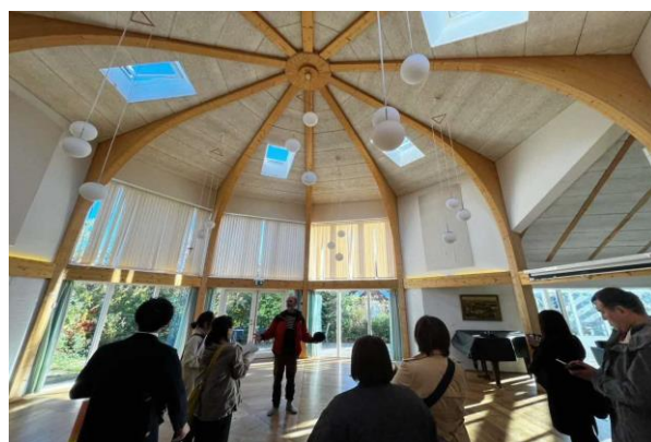
多角形で熱を取り入れやすい構造になっている共同ハウス
