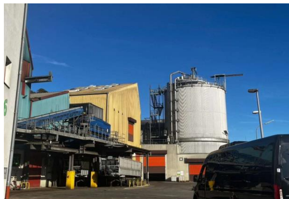
発電プラント
