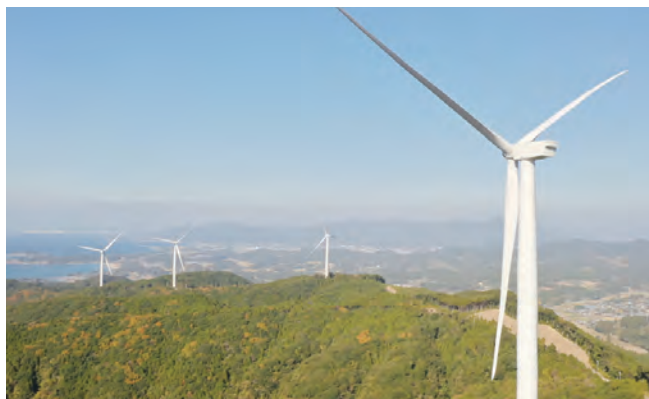
「串間風力発電所」～風車23基を設置した九州最大規模の陸上風力発電所～
